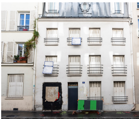
Façade de la pension de famille Rivage (Paris 17 ème ) avant démolition.
